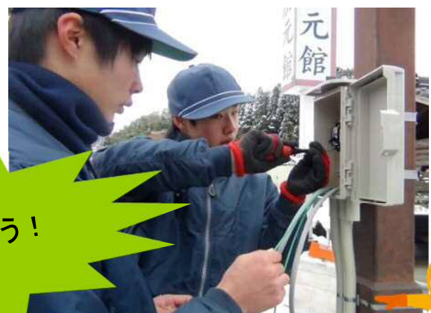
道の駅 駐車場の電源新設工事
