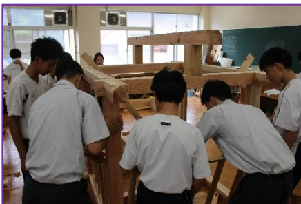
木造小屋組の組立・解体
